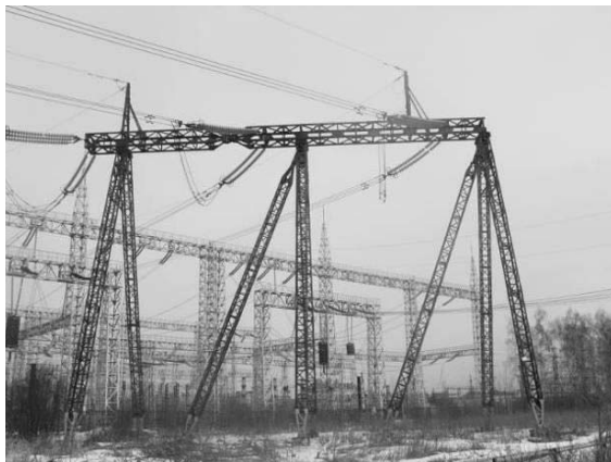
Рис.2. Схема порталної опори ВЛ
